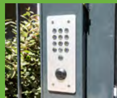
Entrée sécurisée de la résidence
