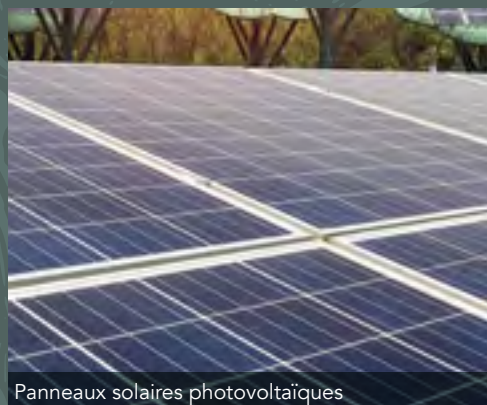
Panneaux solaires photovoltaïques
