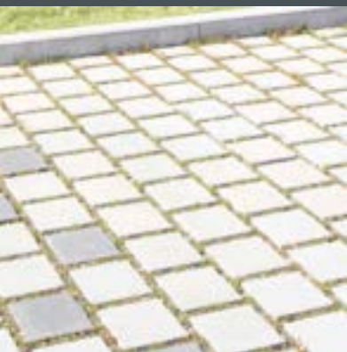
Cheminements et seuil d'accueil en pavés
